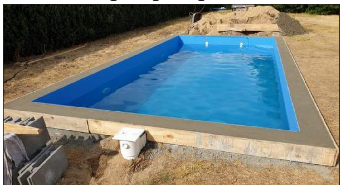
Für Pools in Beton spricht eindeutig die Langlebigkeit, selbst wenn die Anlage vorab merklich mehr Zeit und Arbeit beansprucht, bis das Becken allen Erwartungen entspricht.
